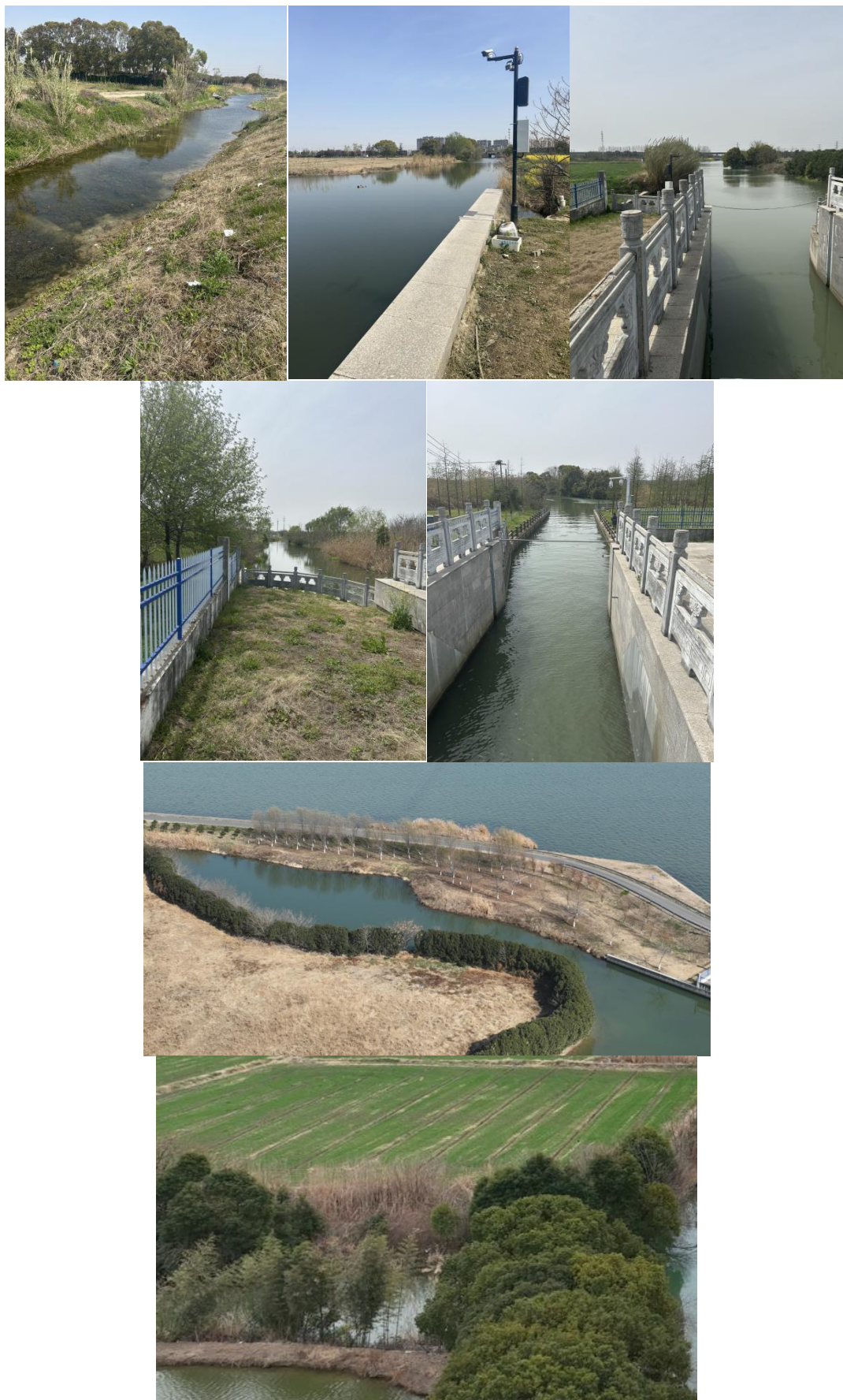
图 3.4.2-2 支浜现场照片
